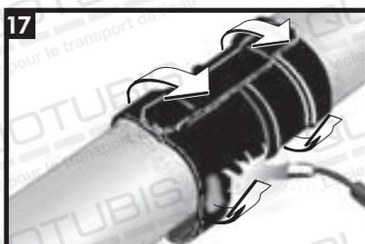
Continuez à chauffer, du centre vers l'une des extrémités du fourreau, jusqu'à ce que la récupération soit achevée. De manière semblable, procédez au chauffage et à la thermorétraction de l'autre côté.
