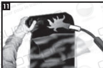
Enlevez partiellement la pellicule recouvrant le fourreau et chauffez soigneusement la croisure du dessous sur environ 150 mm (6 po) à partir de l'extrémité.
