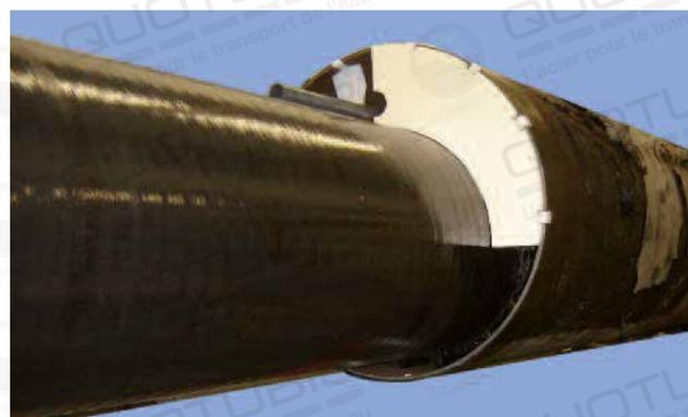
Poser le segment en mousse sur le tube porteur et insérer dans le tube fourreau. Le bord relevé est à l'extérieur, sur la face avant du tube fourreau. Ceci garantit un appui sûr.
