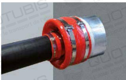
5. Injecter la colle d'étanchéité sous la manchette ainsi que déjà fait sur le côté du tube de protection et monter la deuxième bande de serrage. Étaler la colle d'étanchéité émergente, le cas échéant.
