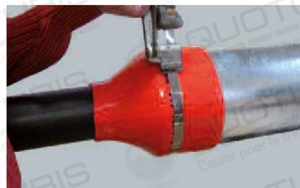
3. Lorsque la tension maximale est atteinte, replier la bande lentement d'un demi-tour environ en lâchant la manivelle.
