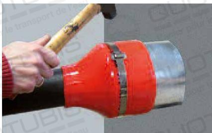
2. Monter la première bande de serrage à une distance de 15 mm environ de l'extrémité du tube de protection
