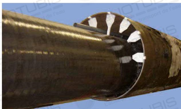
Fixer le support plastique avec clip à la paroi intérieure du tube de montage, couper pour ajuster à la longueur souhaitée, si nécessaire. La distance doit être adaptée aux logements dans les segments de support.
